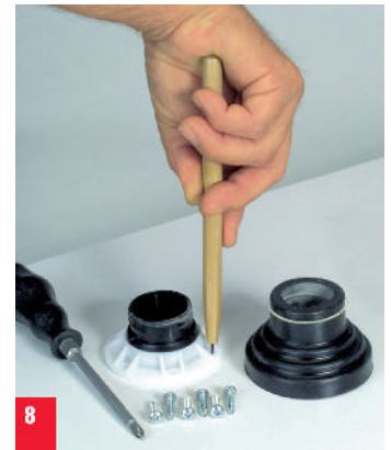
8. Löcher mit Vorstecher einstechen. Bei Kunststoffdächern Löcher mit \varnothing 3,5 mm Bohrer vorbohren.
