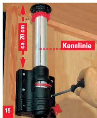
15. Schrauben anziehen. HDM140: 20 cm Abstand zwischen Dach und Haltekonsole HDM141: 9 cm Abstand zwischen Dach und Haltekonsole
