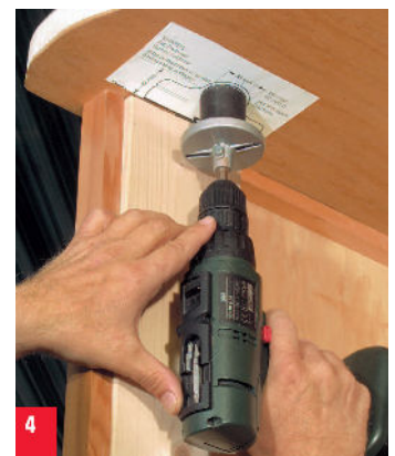
4. Mit dem Kreisbohrer ein Loch von Ø 38 mm von unten bohren.
