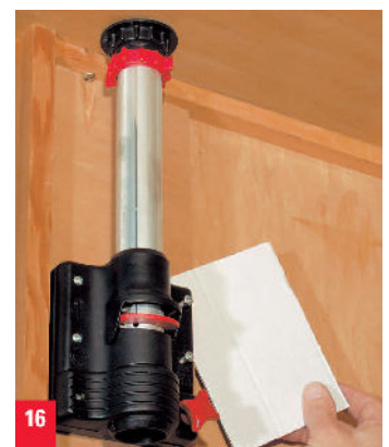
16. Antennenmast senkrecht anbringen, sodass er sich leicht schieben lässt. Falls Antennenmast sich schwer schieben lässt, Unterlage anbringen oder abschleifen.
