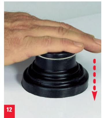
12. Dichtungsmanschette bis zum Aufsitzen aufschieben, ohne diese zu überdrücken.
