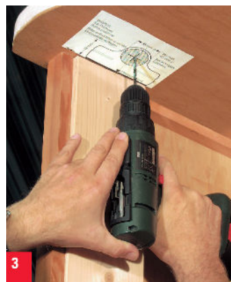
3. Bohrschablone an die Decke anbringen und Zentrierloch bohren. Bohrschablone finden Sie auf Seite 9.
