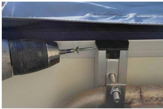
Die Endkappen werden nun in die Montierschienen gesteckt. Sie können optional mit Bohrschrauben fixiert werden.
