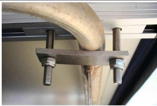
Vervollständigen Sie die Befestigungsklammer mit der Montierplatte und ziehen sie alle Schrauben sorgfältig fest.
