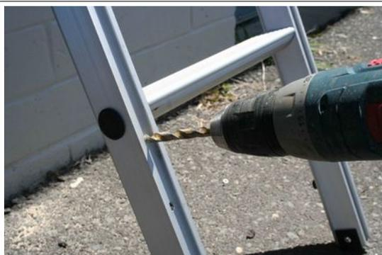
Um die Leiter für niedrigere Fahrzeuge anzupassen muss jeweils ein 8mm Loch oberhalb der existierenden Bohrungen eingefügt werden. Die Löcher müssen groß genug sein um das einrasten beider Sicherheitspins zu gewährleisten.
