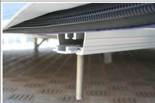
Das Zelt wird an 4 Positionen befestigt. Schieben Sie die Gleitplatten in die vorgesehene Nut der Montierschienen. An jeder Position die fixiert werden will muss sich eine Schraube innerhalb und eine außerhalb des Trägers befinden.
