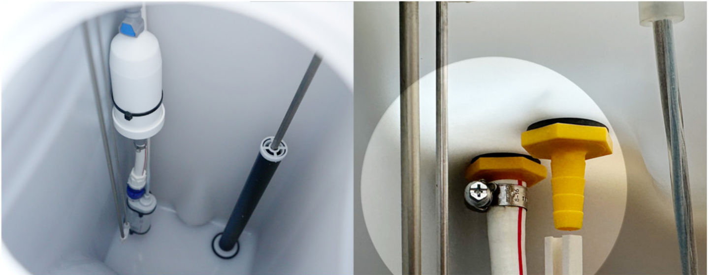
Abbildung 8: Baugruppe vorsichtig in den Tank einsetzen und je nach Hersteller/Modell am Tank befestigen.
