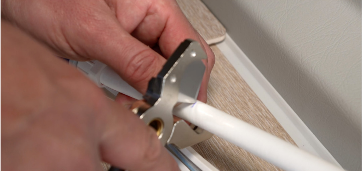
Abbildung 4: Wasserschlauch exakt an den markierten Stellen trennen.
