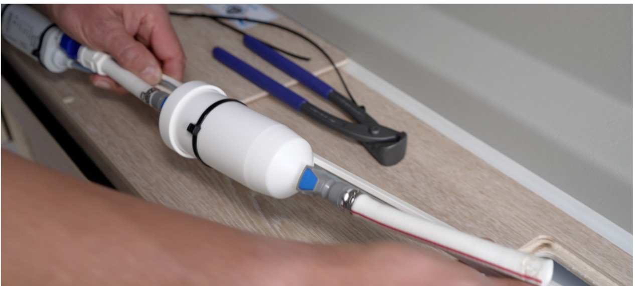
Abbildung 7: Fixieren des bluuwater IT08 Wasserfilters mit Kabelbinder am Kabelkanal (sofern vorhanden).
